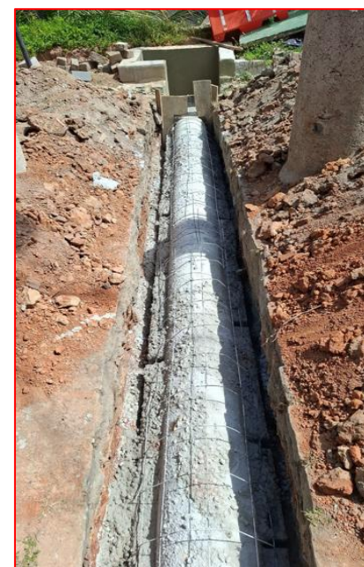
ESCAVAÇÃO DA RUA COM TUBULAÇÃO E PROTEÇÃO LATERAL C/ FERRAGENS E BLOCOS DE CIMENTO
