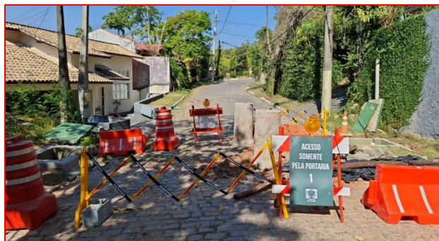
SINALIZAÇÃO PARA INTERDITAR A RUA 2
