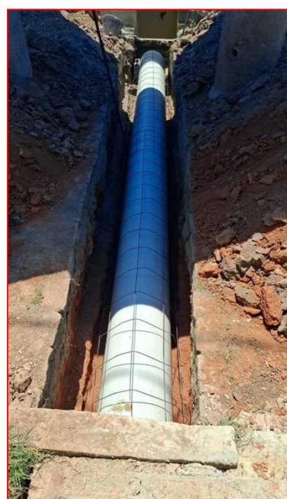
ESCAVAÇÃO DA RUA COM TUBULAÇÃO
