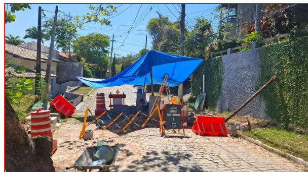
INÍCIO DO TRABALHO ÁGUAS PLUVIAIS
