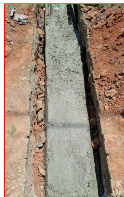
CONCRETAGEM PARA PROTEGER A TUBULAÇÃO
