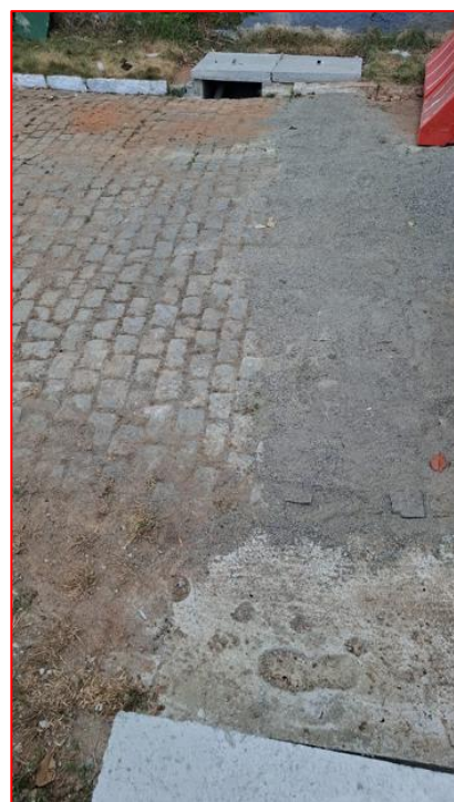
FINALIZAÇÃO DA OBRA
