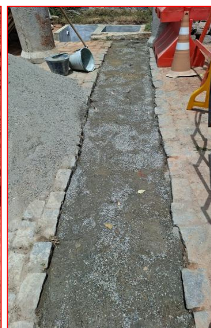
FINALIZANDO COM PÓ DE PEDRA E REGANDO C/ ÁGUA PARA COMPACTAÇÃO
