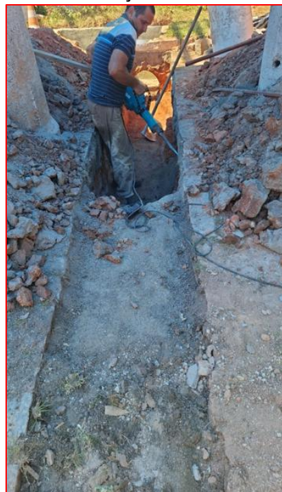
ESCAVAÇÃO DA RUA PARA RECEBER A TUBULAÇÃO
