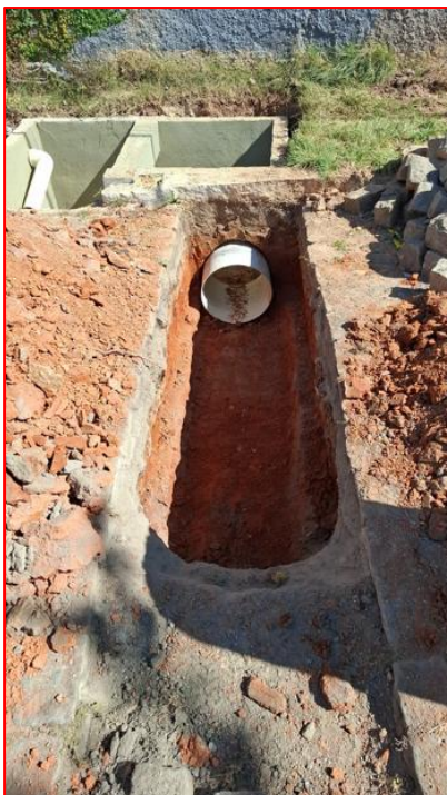
ESCAVAÇÃO DA RUA E MOLDE
