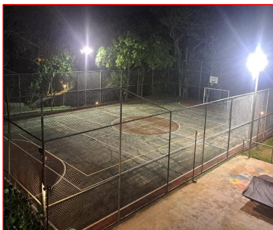
Antes da nova instalação
