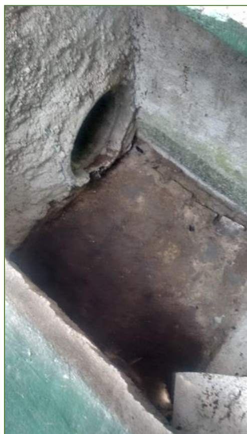
Após a limpeza
