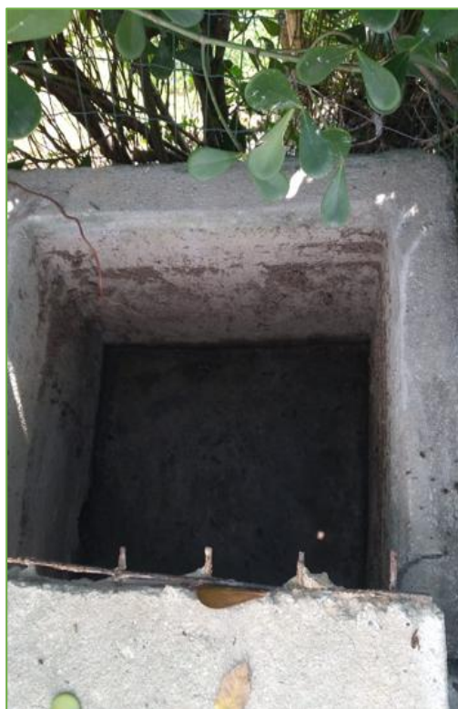
Após a limpeza
