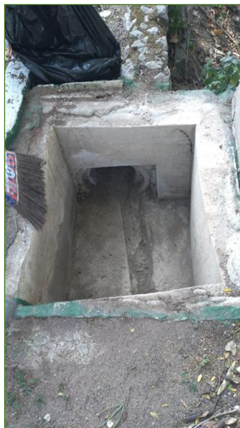
Após a limpeza
