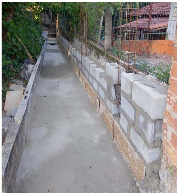
Assentamento dos blocos estruturais do muro estaqueado.
