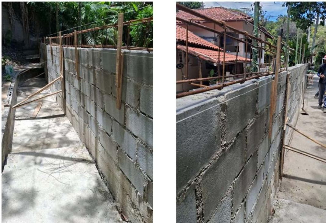
Execução de vigas e pilares do muro estaqueado.
