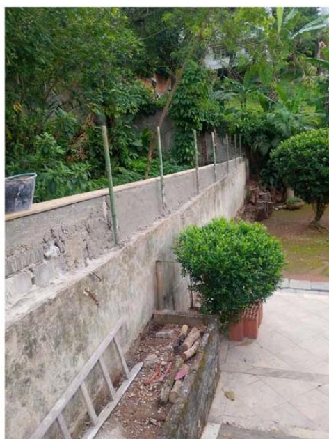
Remoção da vegetação na face interna do muro do Lote 9.
