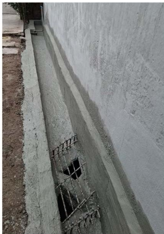
Execução da calha de drenagem no pé do muro do Lote 9.
