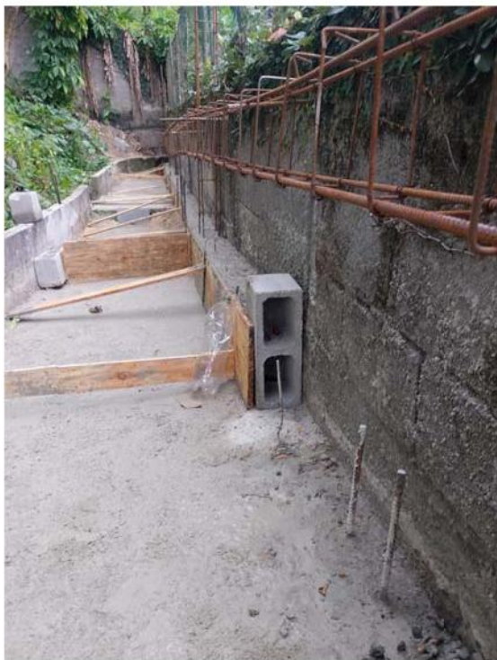
Finalizando a execução das estacas.
