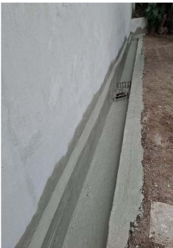
Execução da calha de drenagem no pé do muro do Lote 9.
