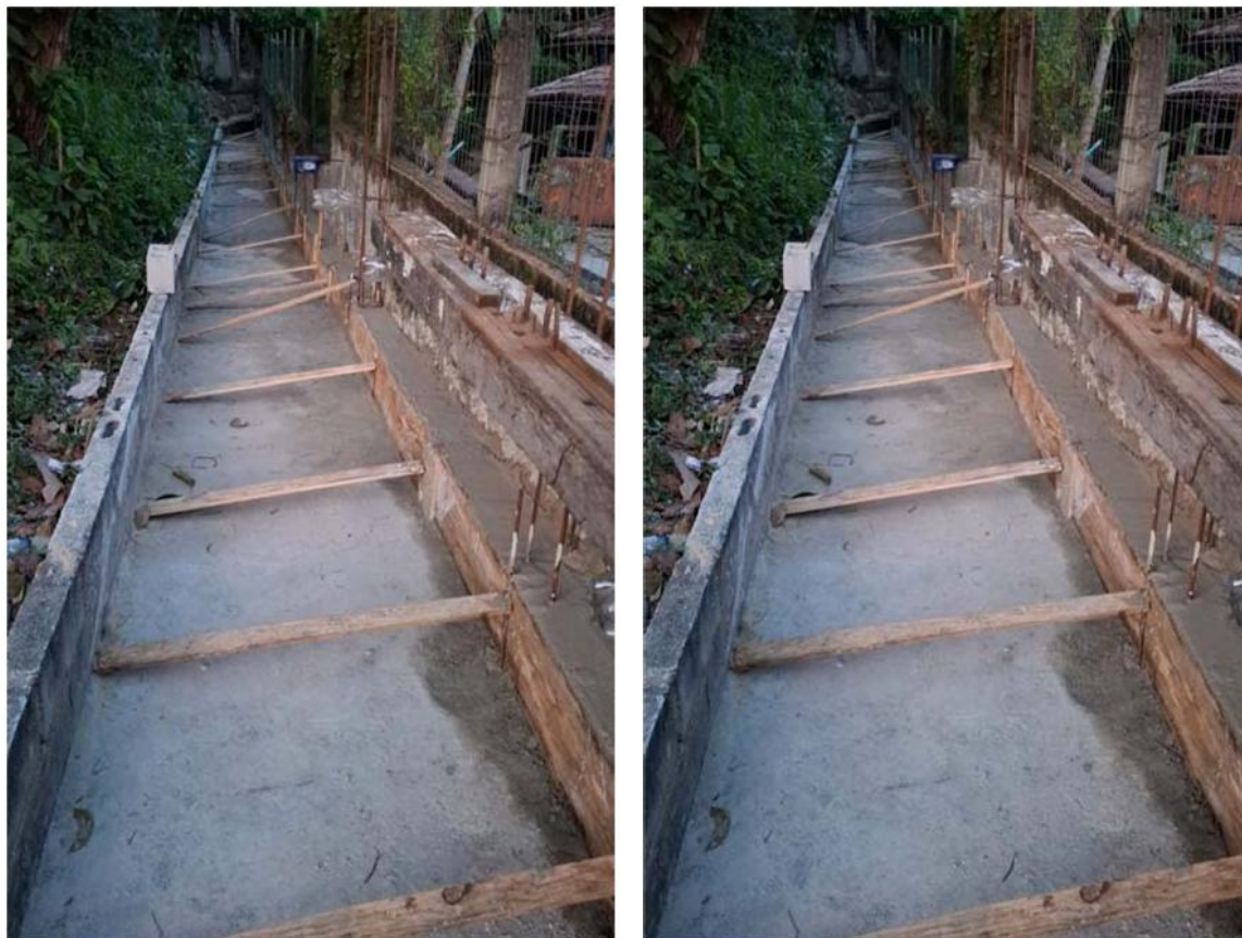
Execução da fundação do muro estaqueado.
