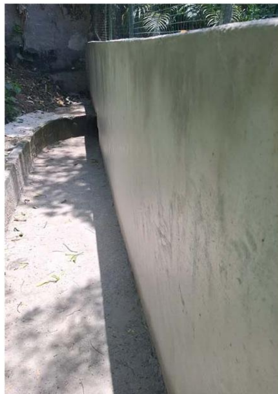
Execução do emboço do muro estaqueado.
