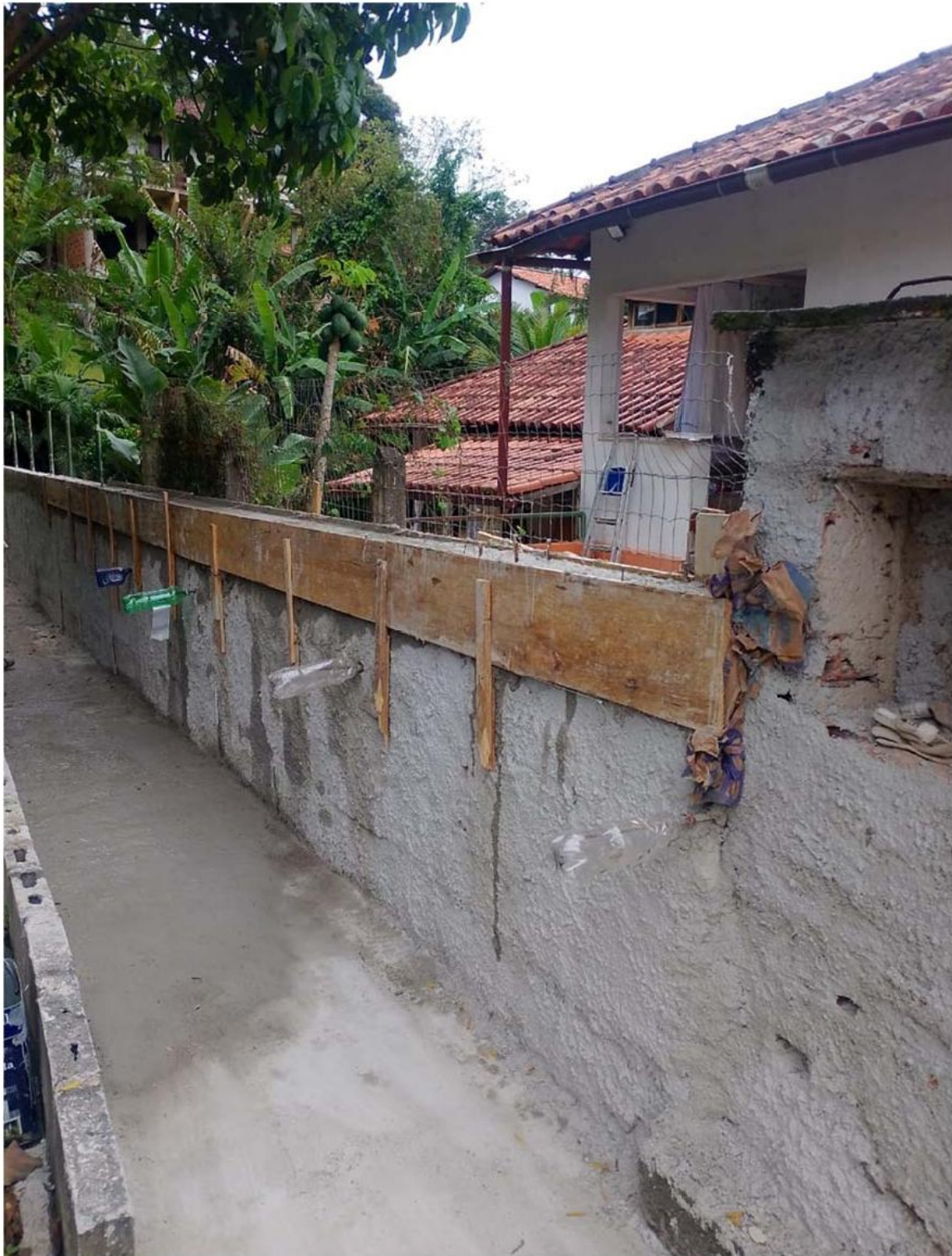
Concretagem da viga de topo do muro estaqueado.
