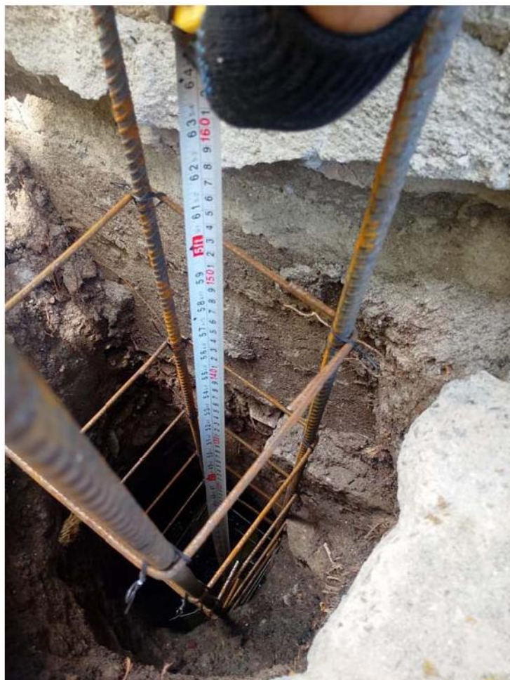
Execução das estacas.
