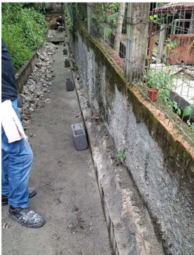
Início dos serviços com a demolição de mureta existente.
